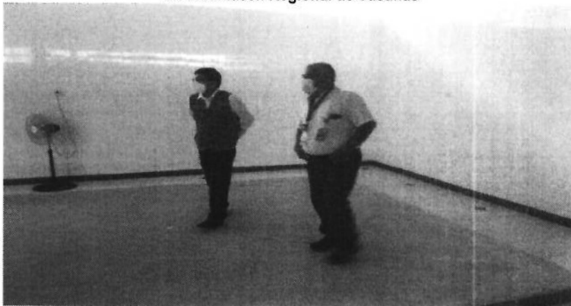
Imagen n.º 2 Espacio para la instalación de la cámara frigorífica adicional en el Almacén Regional de Vacunas
