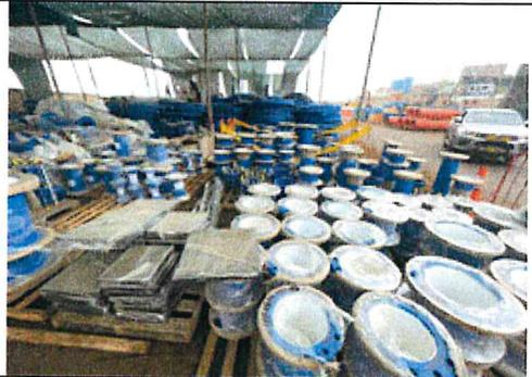
**Accesorios para reservorios y cámaras.** Se aprecian los accesorios en hierro dúctil para reservorios y cámaras dispuestos en el almacén para su posterior instalación. Estos accesorios fueron verificados y aprobados por la Supervisión.
