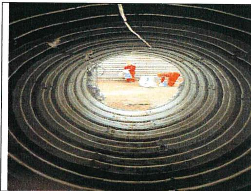
**Túnel 7 - Calango.** Se muestra la ejecución del túnel liner el cual se encuentra culminado y se aprecia a personal realizando labores de limpieza para la instalación posterior de las tuberías de hierro ductil.
