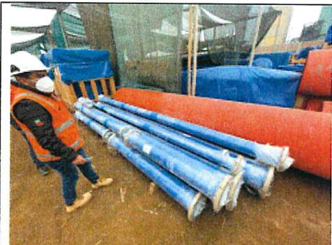
**Accesorios (Niples).** Se aprecian niples fabricados los cuales serán utilizados para los reservorios. Estos accesorios fueron verificados y aprobados por la Supervisión.
