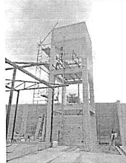
Fotografía N° 4. Tanque elevado en proceso de ejecución.
