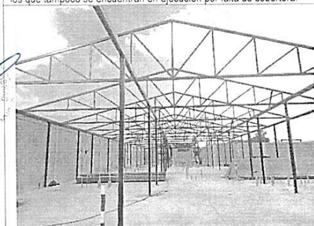
Fotografía N° 9. Otro sector de la construcción que se encuentra pendiente de ejecución por falta de materiales.
