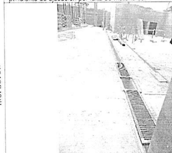
Fotografía N° 11. Pisos y canaletas del área de intervención.
