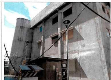
Fotografía N° 16 Se ha ejecutado el bloque F1 de la segunda etapa del proyecto, quedando pendiente su culminación.
