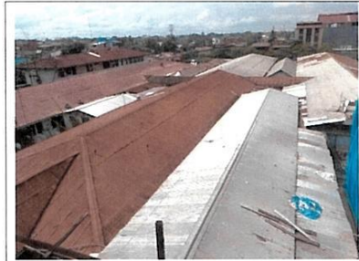
Fotografía N° 15 Área establecida para el emplazamiento del sector F2, el mismo que limita con el sector F3, aún se encuentran ocupadas por Emergencia del hospital antiguo.
