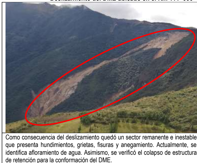
Fotografía N° 1 Deslizamiento del DME ubicado en el Km 111+000
