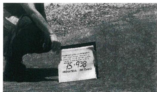
Fotografía N° 03: En la progresiva Km 75+938 se evidencia que la carpeta asfáltica no ha llegado al nivel de la rasante
