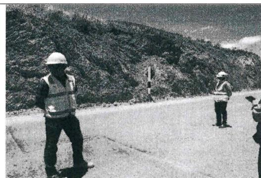
Fotografía N° 01: En el Km. 73+904 se evidencia que la carpeta asfáltica no ha llegado al nivel de la rasante
