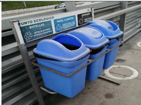
Fotografía N° 61: Vista del punto de acopio de residuos sólidos de la zona de anden – sentido norte, Estación Canadá, se observó que no se cumple con el código de colores para la segregación y almacenamiento de los residuos, conforme al DL 1278 y la NTP 900.058-2019.
