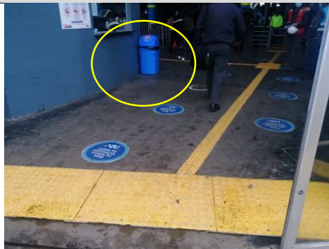
Fotografía N° 55: Vista del punto de acopio de residuos sólidos de la zona de recarga del Terminal Matellini, se observó un contenedor sin etiqueta o rotulo que identifique el tipo de residuo a disponer, asimismo, no se cumple con el código de colores para la segregación y almacenamiento de los residuos, conforme al DL 1278 y la NTP 900.058-2019.
