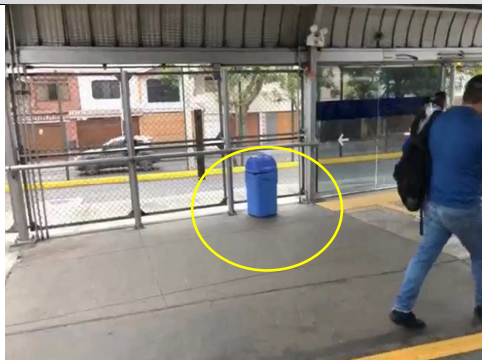
Fotografía N° 54: Vista del punto de acopio de residuos sólidos de la zona de andén del Terminal Matellini, se observó un contenedor sin etiqueta o rotulo que identifique el tipo de residuo a disponer, asimismo, no se cumple con el código de colores para la segregación y almacenamiento de los residuos, conforme al DL 1278 y la NTP 900.058-2019.
