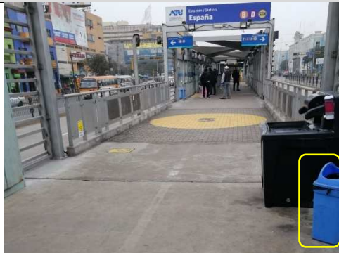
Fotografía N° 65: Vista del punto de acopio de residuos sólidos de la zona de andén – lado Norte de la Estación España, se observó un contenedor de residuos sin tapa y que no cumple con el código de colores para la segregación y almacenamiento de los residuos, conforme al DL 1278 y la NTP 900.058-2019.
