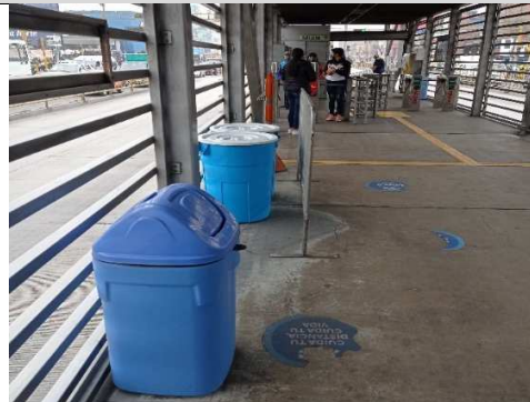
Fotografía N° 72: Vista del punto de acopio de residuos sólidos zona de andén – sentido sur, Estación Tomás Valle, se observó que no se cumple con el código de colores para la segregación y almacenamiento de los residuos, conforme al DL 1278 y la NTP 900.058-2019.
