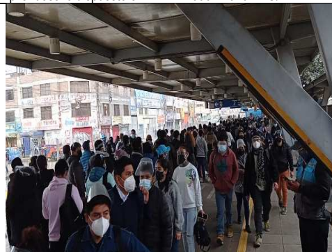
Fotografía N° 53: Vista del andén de embarque del Terminal Naranjal, lado B (Embarque SXN), se observó que no se cumple con el distanciamiento social de 1 metro por parte de los usuarios del servicio, incumpléndose lo dispuesto en RPE N° 0061-2020-ATU/PE
