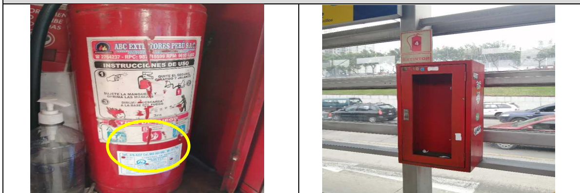
Fotografía N° 14: Vista del porta extintor señalizado, en la zona de andén del embarque N° 1 de la Estación Canadá, en la que no existe el Extintor N° 4.
