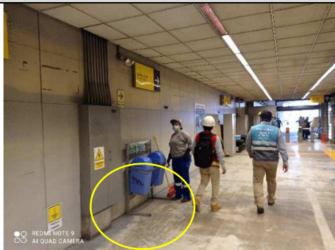
Fotografía N° 67: Vista del punto de acopio de residuos sólidos zona de andén – sentido sur, Estación 2 de Mayo, se observó que no se cumple con el código de colores para la segregación y almacenamiento de los residuos, conforme al DL 1278 y la NTP 900.058-2019.
