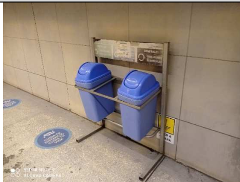
Fotografía N° 68: Vista del punto de acopio de residuos sólidos zona de andén – sentido norte, Estación 2 de Mayo, se observó que no se cumple con el código de colores para la segregación y almacenamiento de los residuos, conforme al DL 1278 y la NTP 900.058-2019.
