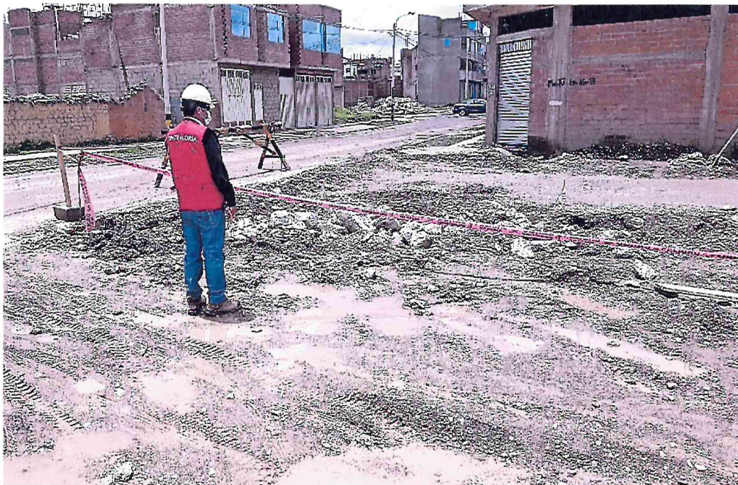
Imagen n.° 12 Restos de material excedente y demoliciones en la construcción de la obra
