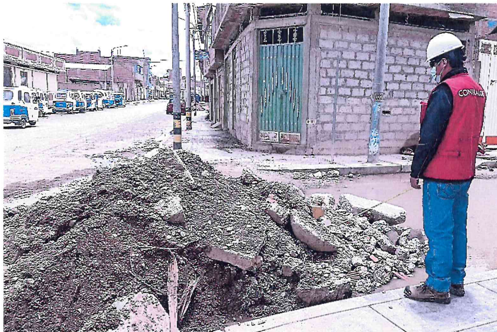
Imagen n.º 13 Restos de material excedente y demoliciones en la construcción de la obra
