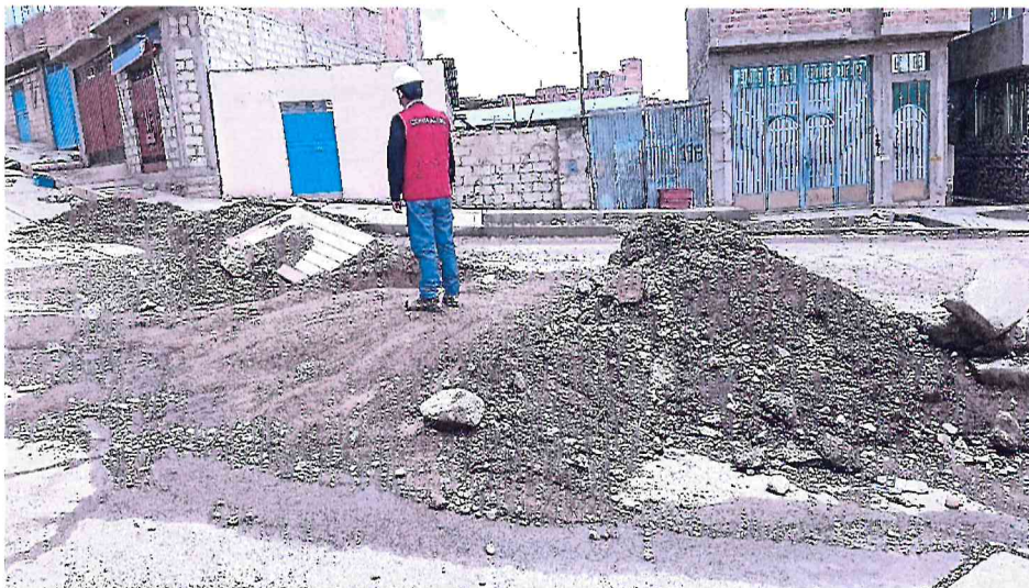
Imagen n.° 11 Restos de material excedente en la construcción de la obra
