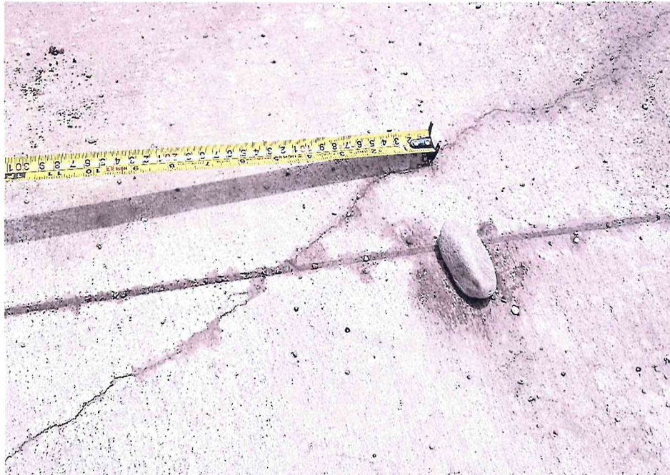
Imagen n.º 1 Fisuras en pavimento rígido de concreto f_c=210 kg/cm 2
