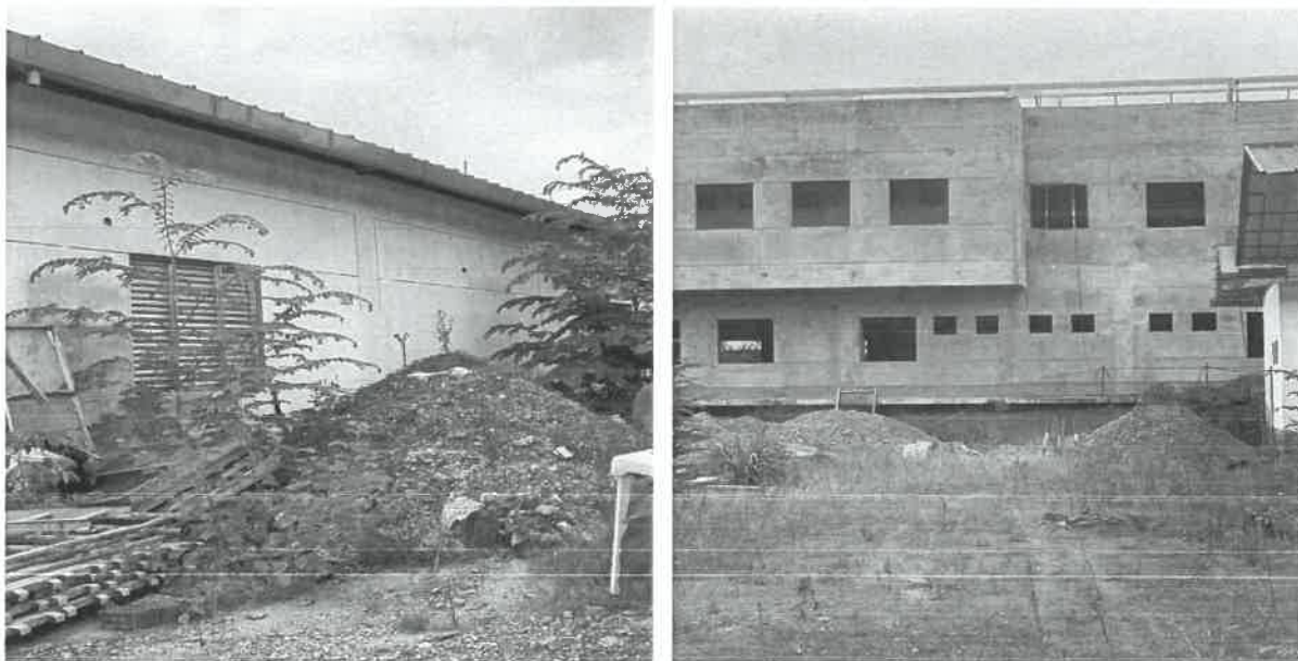
En la toma fotográfica se muestra, sin trabajo alguno del personal obrero, acumulación de materiales de construcción (agregado), ubicadas en el interior de la obra.
