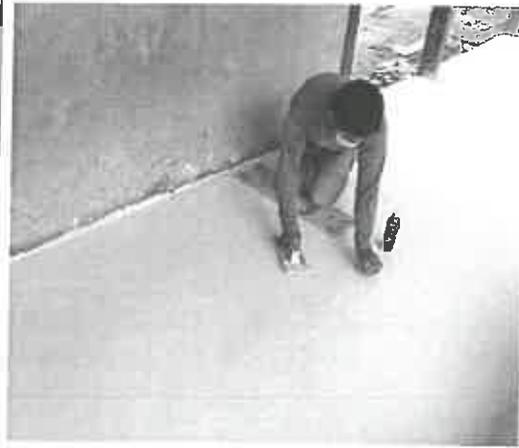
En la fotografía se aprecia que, el personal viene realizando trabajos de granito pulido en el piso de los corredores técnicos, sin la utilización de la ropa de trabajo ni casco de seguridad.
