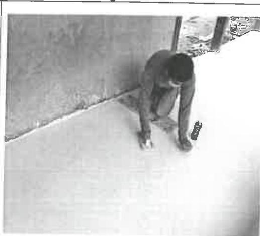
En la fotografía se aprecia que, el personal viene realizando trabajos de granito pulido en el piso de los corredores técnicos, sin la utilización de la ropa de trabajo ni casco de seguridad.
