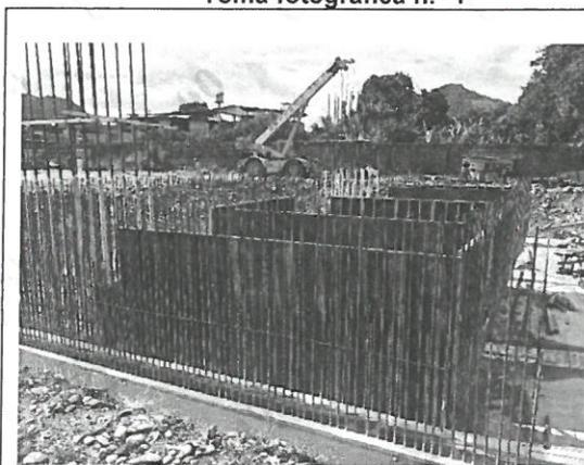
Se observa en la fotografía, los trabajos de encofrados con paneles de madera, en el estribo izquierdo; asimismo se observa la grúa hidráulica de elevación para los trabajos de manipulación de los elementos estructurales.
