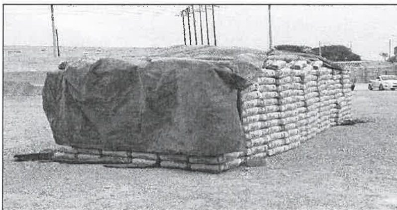
VISTA DEL ÁREA DONDE SE ALMACENA EL CEMENTO
