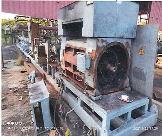
**Figura n.º 8 – Cableado de generador cortado**
