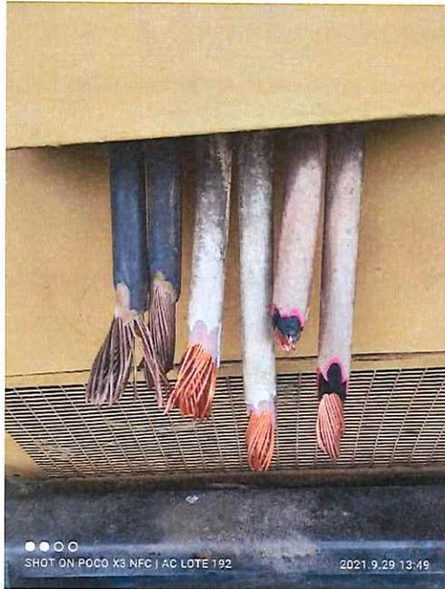
Figura n.º 14 – Tablero de control vandalizado
