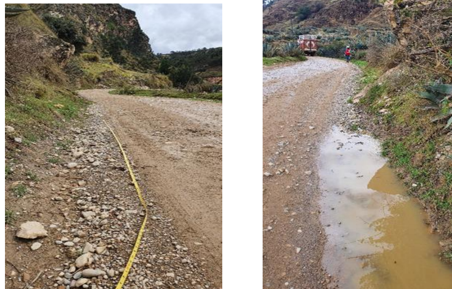
Cuneta colmatada en una longitud de 15.00 mt. Perdida de la sección transversal (Ancho actual=0.16 mt x profundidad actual=0.05 mt)
