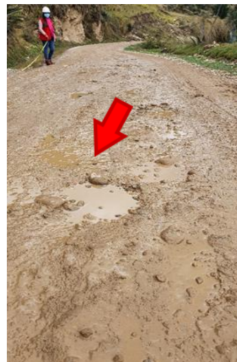
Baches de manera permanente desde la progresiva 5+507 Km. al 5+600 Km
