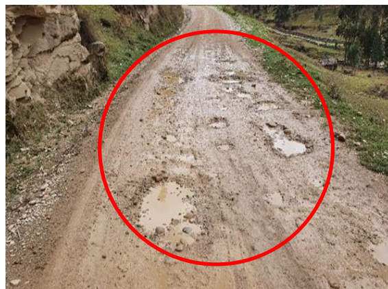
Baches de manera permanente desde la progresiva 5+005 Km. al 5+025 Km
