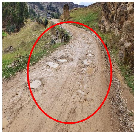
Baches de manera permanente desde la progresiva 5+005 Km. al 5+025 Km
