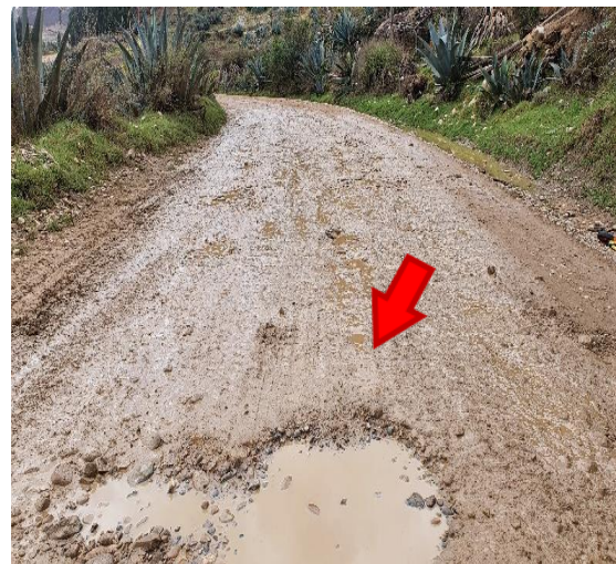
Baches de manera permanente desde la progresiva 5+507 Km. al 5+600 Km
