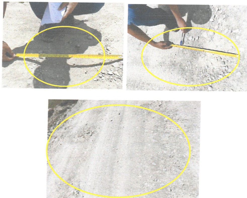
Baches en la progresiva 13+000 km al 15+000 km.
