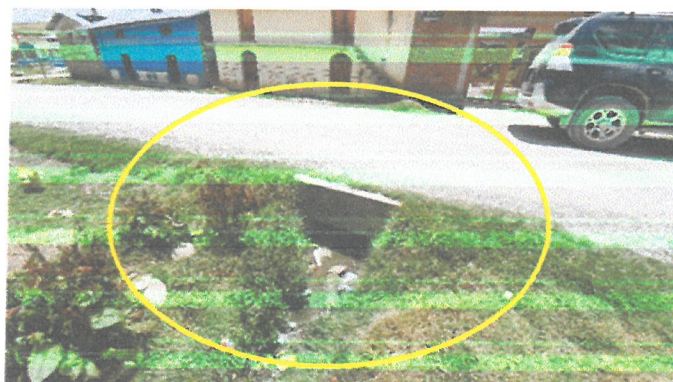
Alcantarillas de concreto colmatadas al 66.67% en la progresiva 24+850 km.
