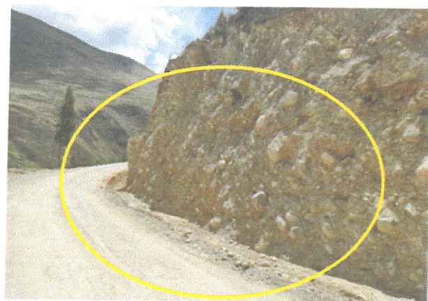
Cunetas colmatadas desde la progresiva 3+380 km. Al 3+420 km
