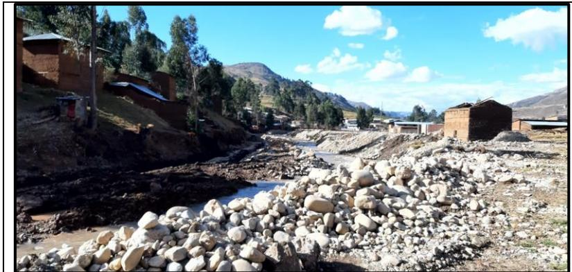
**Fotografía n.º 4:** Falta de seguridad y señalización que permite el ingreso a personas ajenas a la obra.
