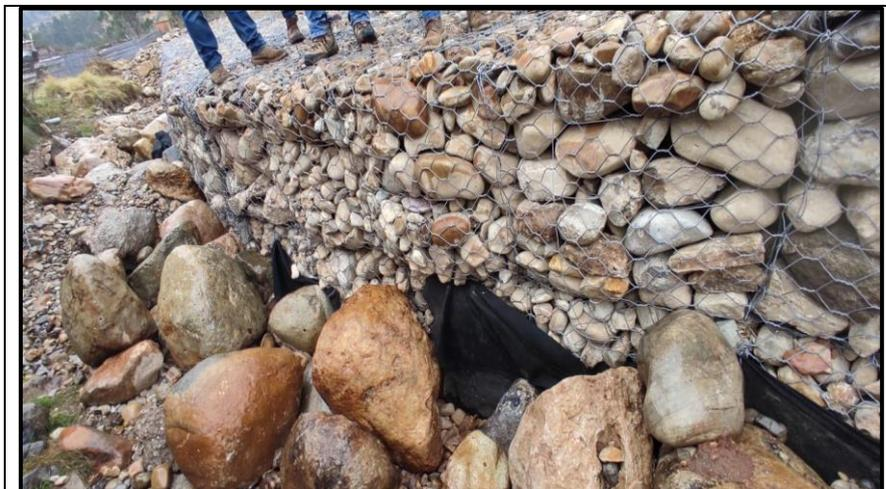
**Fotografía n.º 7:** Deficiente distribución de las piedras colocadas en el muro con gavión
