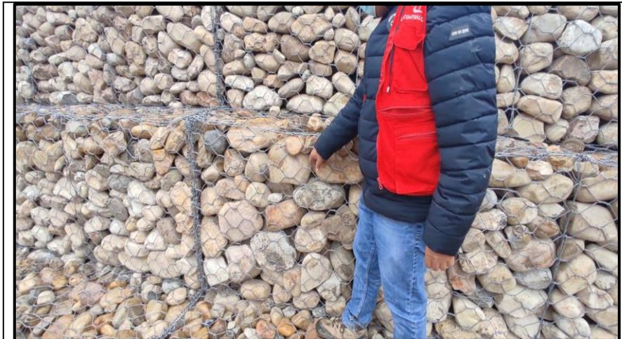
**Fotografía n.º 8:** Deficiente distribución de las piedras provoca vacíos en el muro con gavión.
