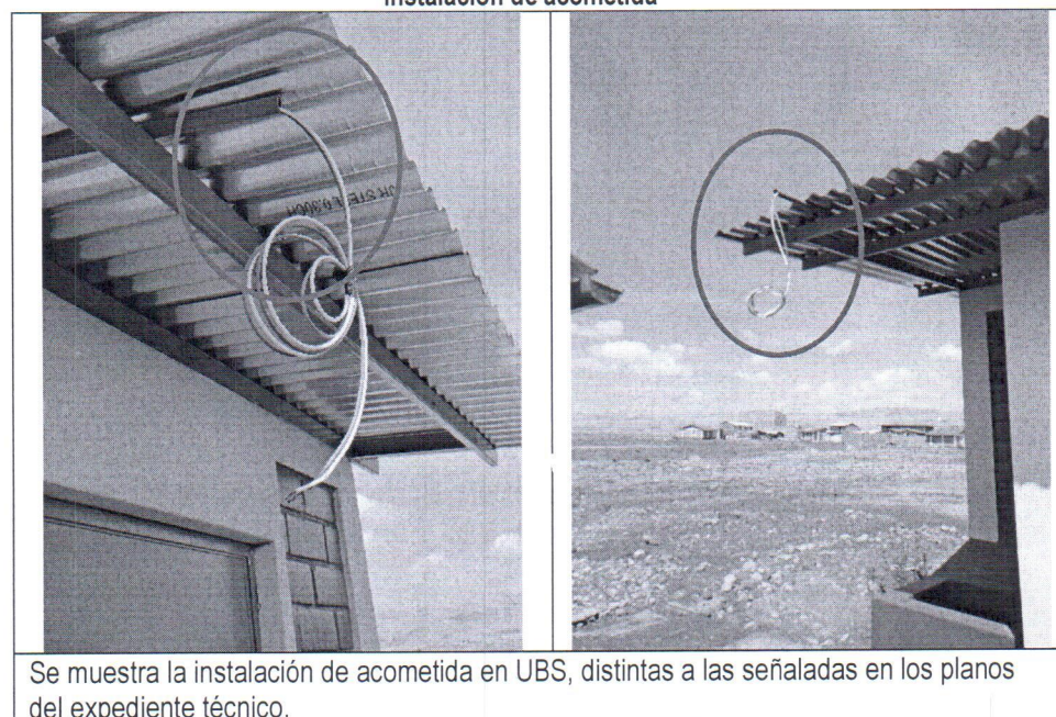
Imagen n.º 2 Instalación de acometida
