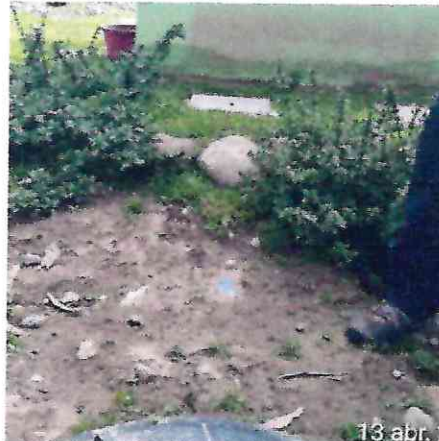
Fuente: Registro fotográfico del acta de constatación de 13 de abril de 2021
