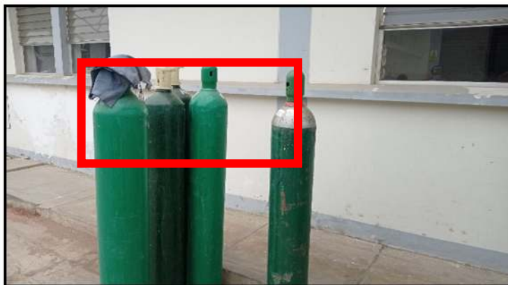
IMAGEN N° 6 BALONES DE OXÍGENO MEDICINAL SIN CADENAS DE SUJECCIÓN
