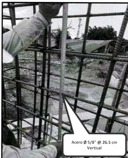
Imagen n.º 11 Distribución de acero Vertical en Muro de Contención – Paño n.º 8
