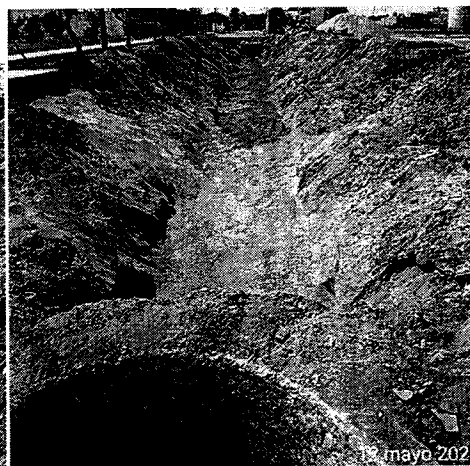
Vista de zanja con relleno de arena de préstamo húmeda que tapa tubería colector instalada en la calle Rubén Darío entre la calle 15 y calle s/n.
