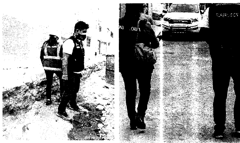
Visita de Inspección Física de 6 de mayo 2021
