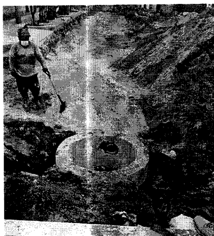
Vista de buzón (buzón 28) ubicado en la calle 29 en la intersección de la calle 19.
