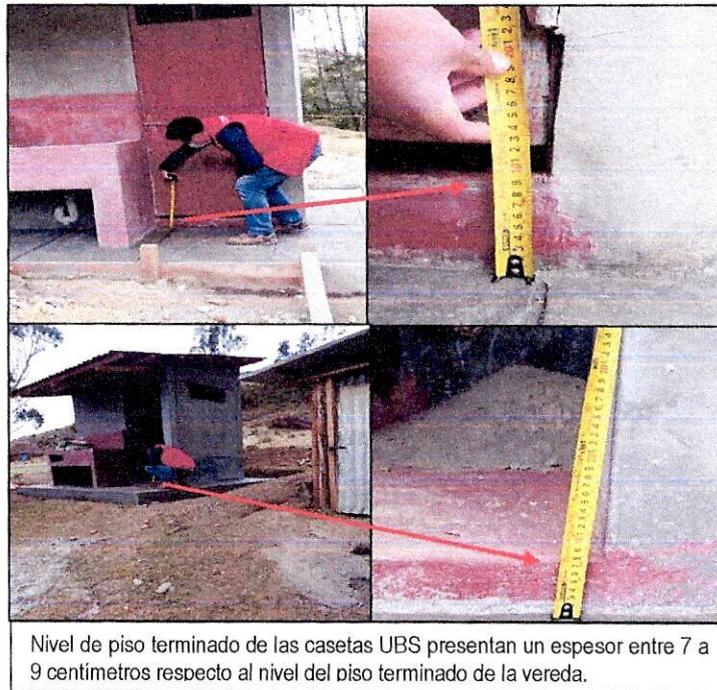
Nivel de piso terminado de las casetas UBS presentan un espesor entre 7 a 9 centímetros respecto al nivel del piso terminado de la vereda.
