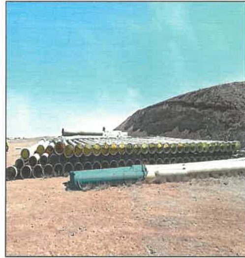
Imagen n.º 6: Tubería de GRP de 400, 600 y 800 mm de diámetro de hasta 12 metros de longitud aproximadamente, expuestas a los rayos ultravioletas de la zona, donde además se carece de un cerco perimétrico de seguridad.
