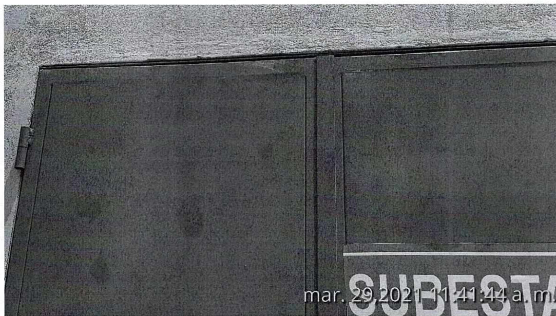
Imagen n.º 1 Puerta de ingreso de la Sub Estación.
