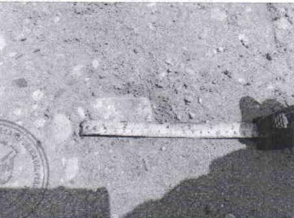
Agregado con medida de 3" colocado y compactado en OBRA para base granular (02/09/2021)
