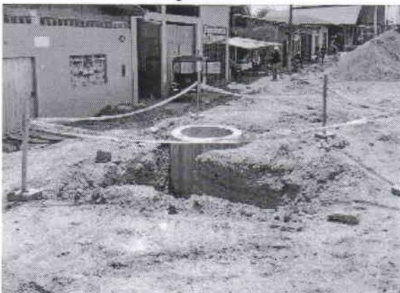
Excavación y buzón sin tapa no limitados con malla de seguridad (02/09/2021)
