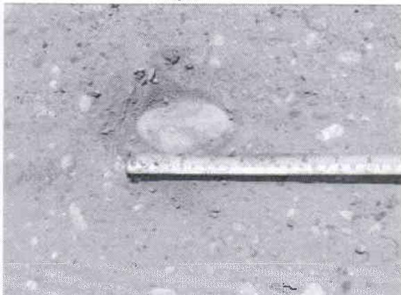
Agregado con medida de 3.5" colocado y compactado en OBRA para base granular (02/09/2021)
