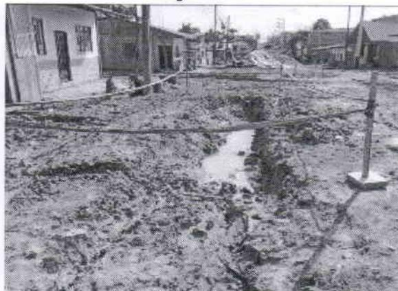
Excavación sin malla de seguridad (31/08/2021)
