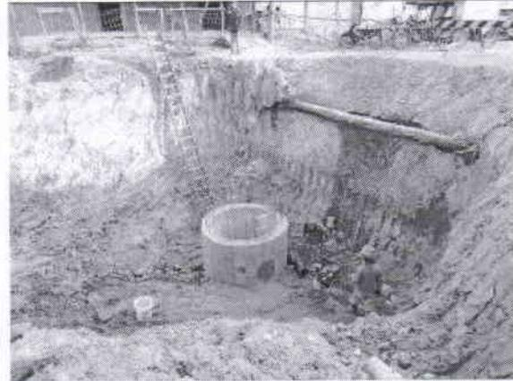
Excavación de zanja, conexión de empalme de Buzones 13 al 14, UP de Alcantarillado (27/08/2021)
