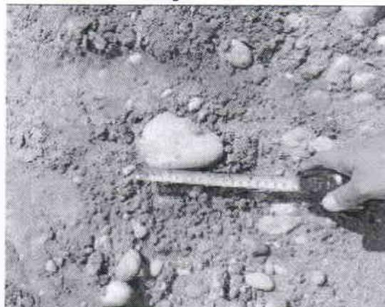
Agregado con medida de 4.5" colocado en OBRA para base granular (02/09/2021)
