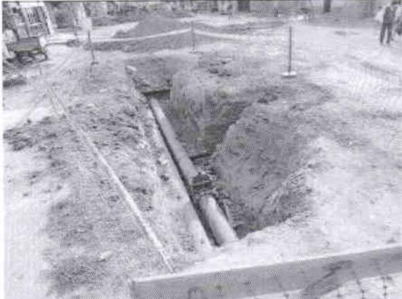
Tubería paralelo al existente en para conexiones domiciliarias de agua, UP Agua Potable (27/08/2021)
