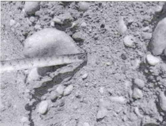
Agregado con medida de 4" colocado en OBRA para base granular (31/08/2021)
