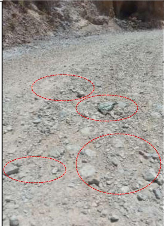
**Comentario:** Progresiva Km4+900 a 5+180, se observa material granular (piedras) más de 15 centímetros (tamaño de un lapicero).
