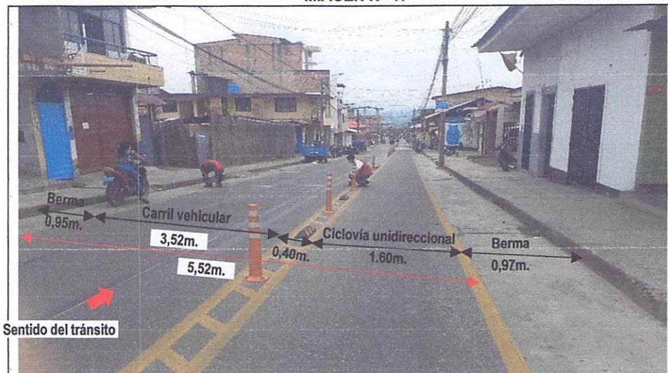
Vista del Jr. José Olaya C-6; se implementó la ciclovia en lado derecho, habiéndose reducido el ancho del carril vehicular de 5,52 a 3,52m. y se observa elementos de segregación instalados: bolardos de polietileno (29 und) y topellantas de caucho (23 und), así como señalización horizontal (pintura en pavimento color amarillo: líneas continuas y diagonales).
