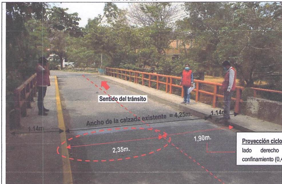
Puente Samaniego, sobre el río Shilcayo. Se tiene un ancho de calzada de 4,25m. y veredas de 1,14m. a ambos lados. Se dispondría de ancho de carril vehicular de 2,35m., cuyo sentido de flujo de recorrido sería desde Tarapoto a La Banda de Shilcayo.
