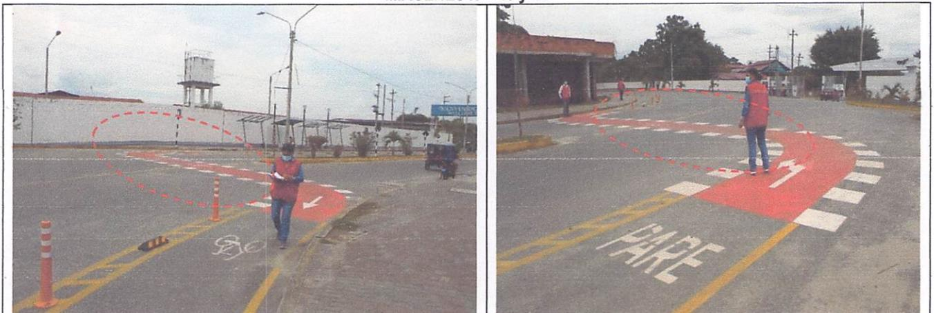
Vistas del **cruce de la ciclovía** del lado derecho hacia el lado izquierdo en zona de llegada al aeropuerto (Av. Aviación), casi en ángulo recto; no se observa señal de control de tráfico (semáforo), lo que representaría peligro para los ciclistas toda vez que la señalización vertical es insuficiente para garantizar la integridad de los usuarios.
