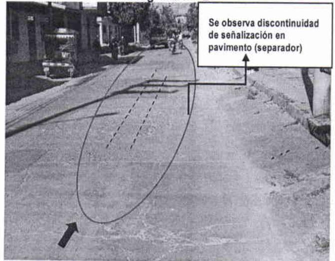
Vista del Jr. Jr. Libertad, cuadra 09. Se observa que el pavimento de la calzada, presenta fisuras, grietas, en dirección del trazo de la demarcación del confinamiento para la ciclovía, no habiendo uniformidad en la superficie de rodadura.
