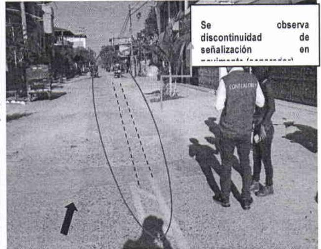
Vista del Jr. Libertad, **cuadra 06**. Se observa que el pavimento de la calzada, presenta fisuras, grietas, en dirección del trazo de la demarcación del confinamiento para la ciclovia, **no habiendo uniformidad en la superficie de rodadura.**
