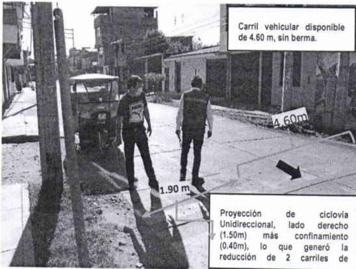
Vista del Jr. Libertad, cuadra 10. Se observa trabajos realizados de señalización en pavimento con color amarillo(separador), al lado derecho de la vía, el flujo vehicular es de un solo sentido, además el desgaste de la pintura de tráfico es inminente.
