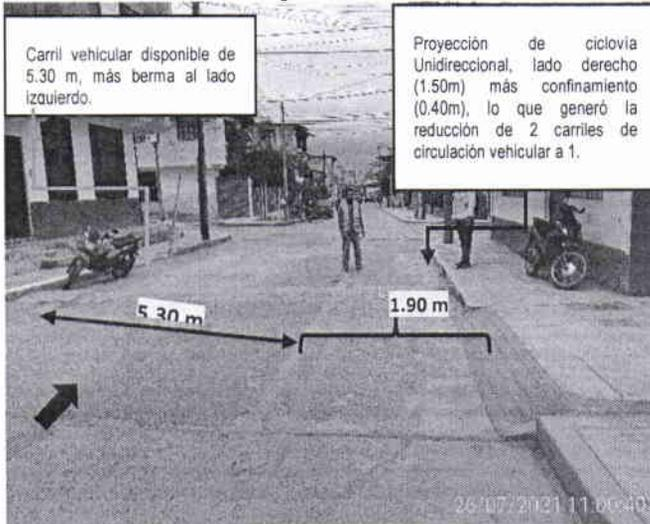
Vista del Jr. Reyes Guerra, **cuadra 05**. Se observa trabajos realizados de señalización en pavimento con color amarillo(separador), al lado derecho de la vía. El flujo vehicular es de un solo sentido, **además el desgaste de la pintura de tráfico es inminente.**
