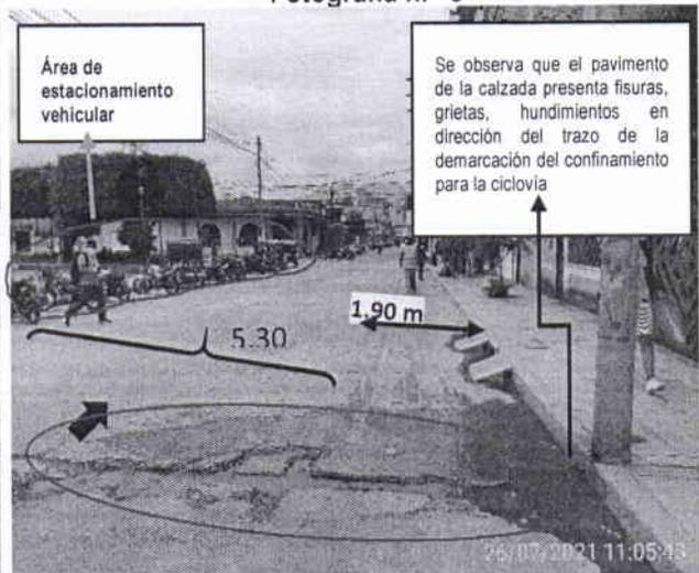
Vista del Jr. Reyes Guerra, **cuadra 06**. Se observa trabajos realizados de señalización en pavimento con color amarillo(separador), al lado derecho de la vía. El flujo vehicular es de un solo sentido, **asimismo, no existe uniformidad en la superficie de rodadura.**
