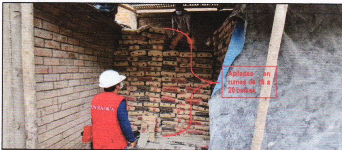
Imagen n.º 2 Almacén de obra
