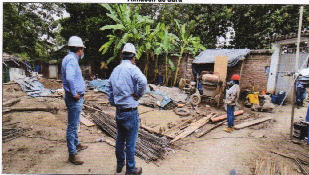
Imágenes n.ºs 3 y 4: Almacén de obra
