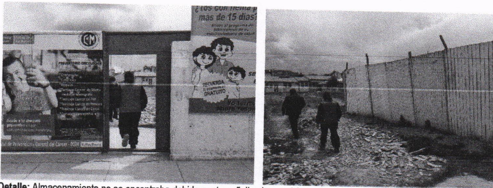
Detalle: Almacenamiento no se encontraba debidamente señalado panel fotográfico del 12 de febrero de 2021.
