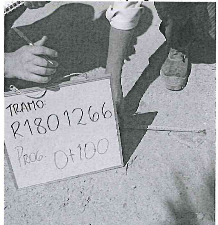
Imagen n.º 10 Material granular superior a 2" ubicado en el tramo R1801266, progresiva 0+100
