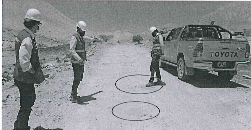
Imagen n.º 24 Ejecución de trabajos de bacheo con material fino y arcilloso en forma circular; ubicado en el tramo MO-607 progresiva 7+950
