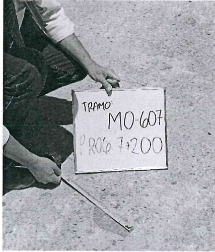
Imagen n.º 7 Material granular superior a 2" ubicado en el tramo MO-607, progresiva 7+200
