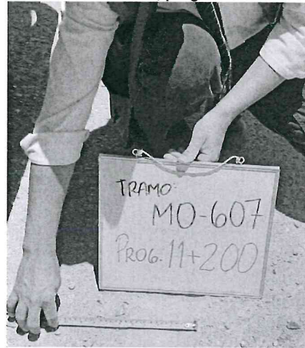
Imagen n.º 8 Material granular superior a 2" ubicado en el tramo MO-607, progresiva 11+200
