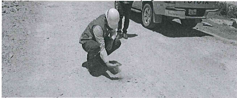
Imagen n.º 25 Ejecución de trabajos de bacheo con material fino y arcilloso en forma circular; ubicado en el tramo MO-607 progresiva 7+950
