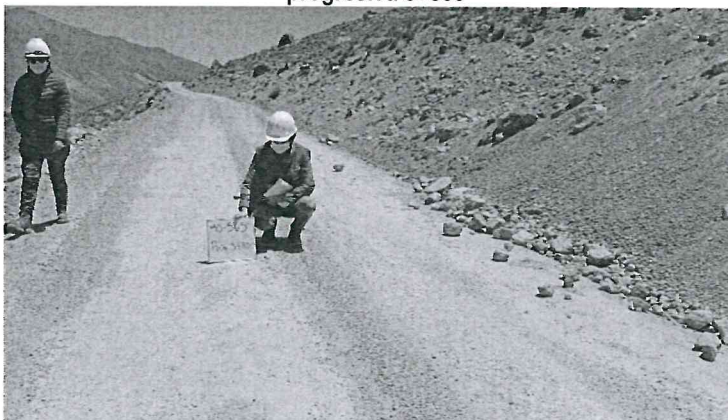
Imagen n.º 26 Desplazamiento de rocas obstaculizan vía en el tramo MO-565, progresiva 3+800
