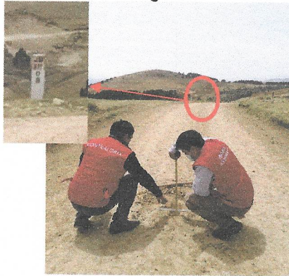
Inspección realizada ruta vecinal JU-817
