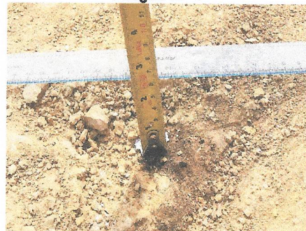
Prospección con espesor de capa rodadura de 6.5 centímetros
