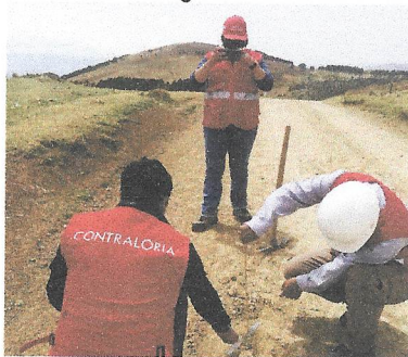
Prospección con espesor de capa rodadura de 6.5 centímetros.
