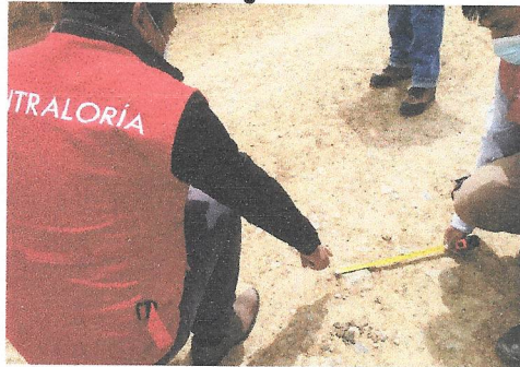
Traslape de la ruta vecinal JU-817 con vía departamental JU-113, muestra rocas mayores a dos (2) pulgadas.
