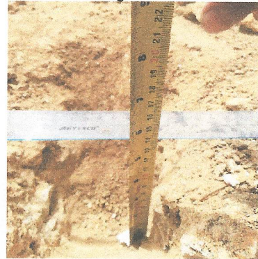
Prospección con espesor de capa rodadura de catorce (14) centímetros.
