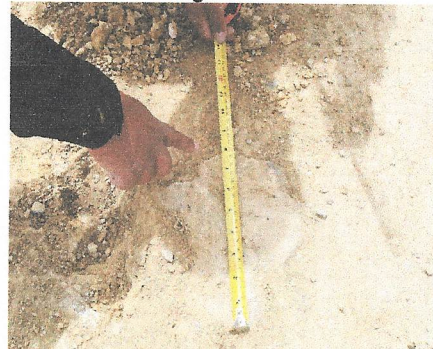
Traslape de la ruta vecinal JU-817 con vía departamental JU-113, muestra rocas mayores a dos (2) pulgadas.
