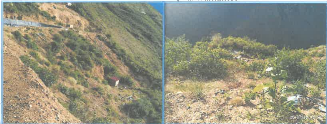
Fotografía n.º 11 No se cuenta con acceso a la poza de monitoreo
