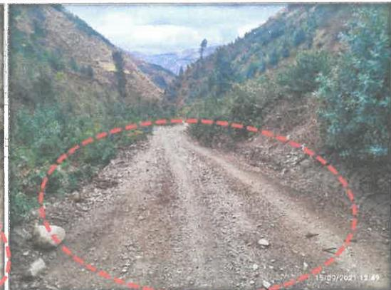
En la imagen se aprecia que se tiene acumulación de tierra en la cuneta y desgaste del material afirmado.
