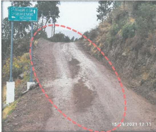
En la imagen se aprecia que en el inicio del tramo se presenta desgaste del material afirmado.
