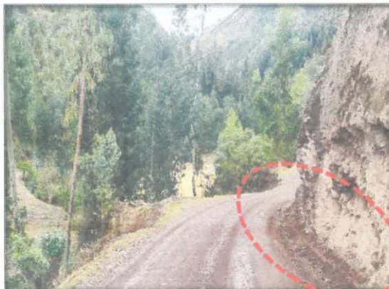
En la imagen se aprecia que se tiene acumulación de tierra en la cuneta.
