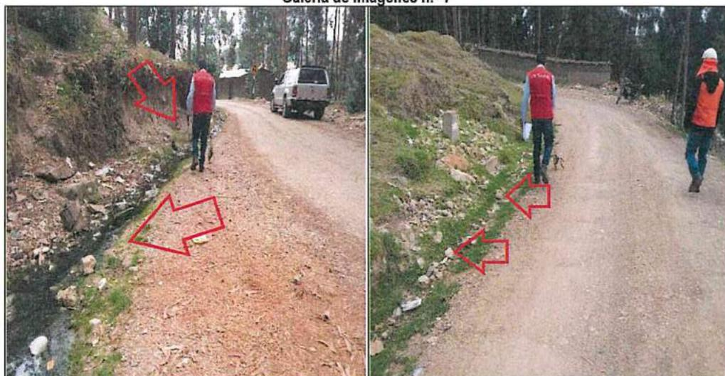
**Imagen n.º 15:** Cunetas de tierra saturadas para el drenaje pluvial 0+280 al 0+362
