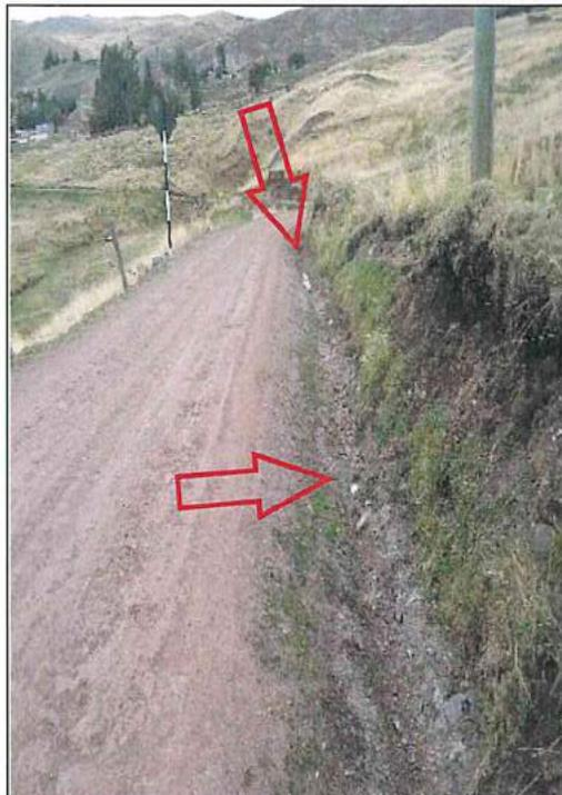
Imagen n.º 9: falta de limpieza en talud de cunetas 0+176 al 0+200
