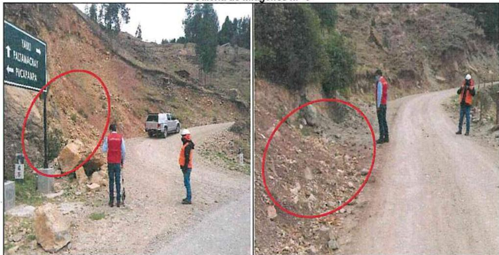
**Imagen n.º 13:** Deslizamiento de tierra y rocas en cunetas 0+000 al 0+070
