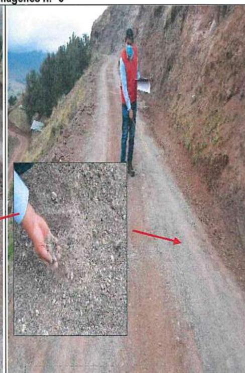
Imagen n.º 12: Material suelto superficial en la plataforma sin compactar 0+176 al 0+200
