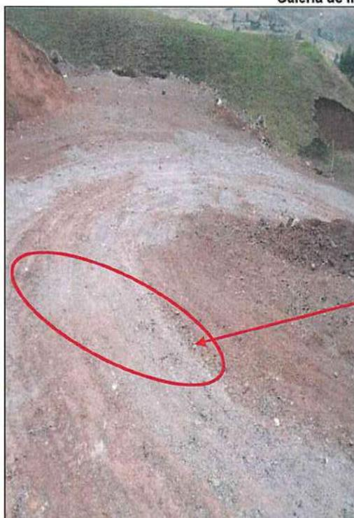
Imagen n.º 11: Material suelto superficial en la plataforma sin compactar 0+176 al 0+200
