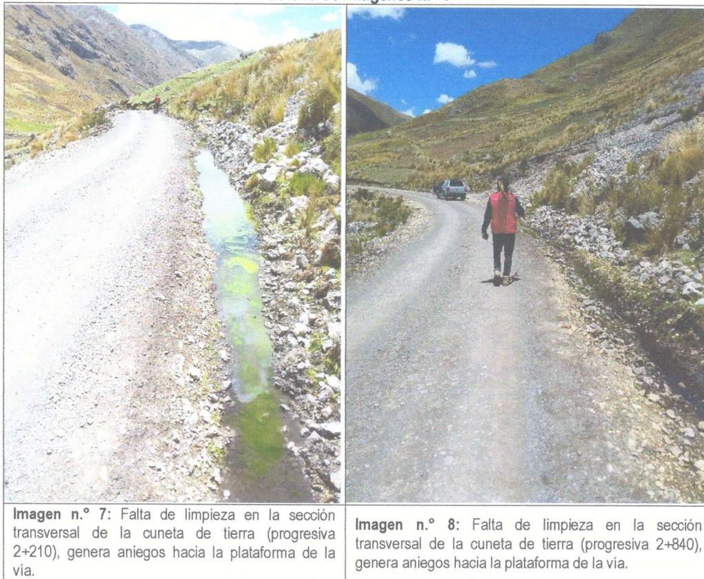
**Imagen n.º 7:** Falta de limpieza en la sección transversal de la cuneta de tierra (progresiva 2+210), genera aniegos hacia la plataforma de la vía.
