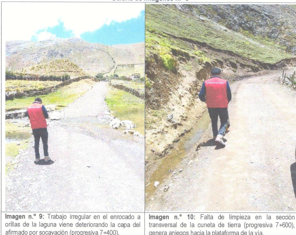
**Imagen n.º 9:** Trabajo irregular en el enrocado a orillas de la laguna viene deteriorando la capa del afirmado por socavación (progresiva 7+400).
