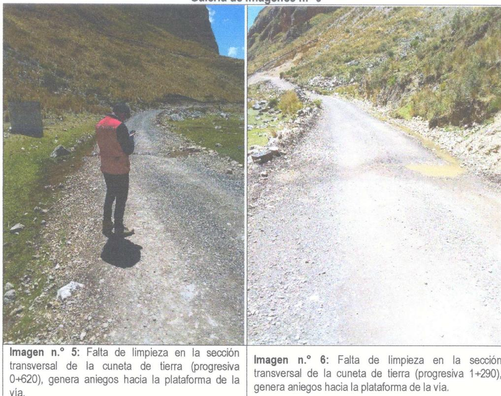
**Imagen n.º 5:** Falta de limpieza en la sección transversal de la cuneta de tierra (progresiva 0+620), genera aniegos hacia la plataforma de la vía.
