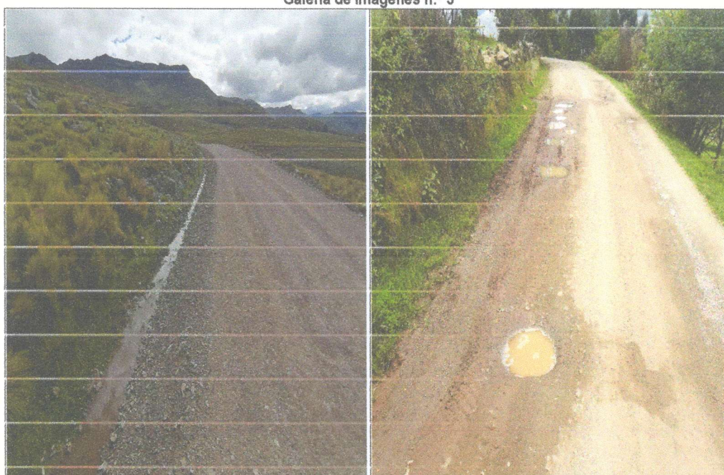
Imagen n.º 5: La cuneta de tierra desde la progresiva 0+000 a la progresiva 6+060 del tramo 2, presenta empozamiento debido a la falta de perfilado de la sección transversal.
