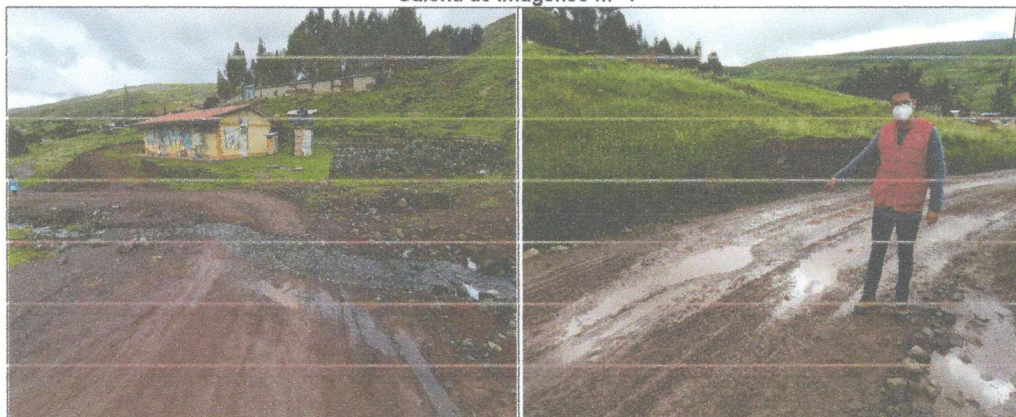
Imagen n.º 1: La cuneta de tierra en la progresiva 0+500 del tramo 1, presenta empozamiento lo cual humedece el lado iderecho de la capa de afirmado de la carretera, aproximadamente en una distancia de quince (20) metros.
