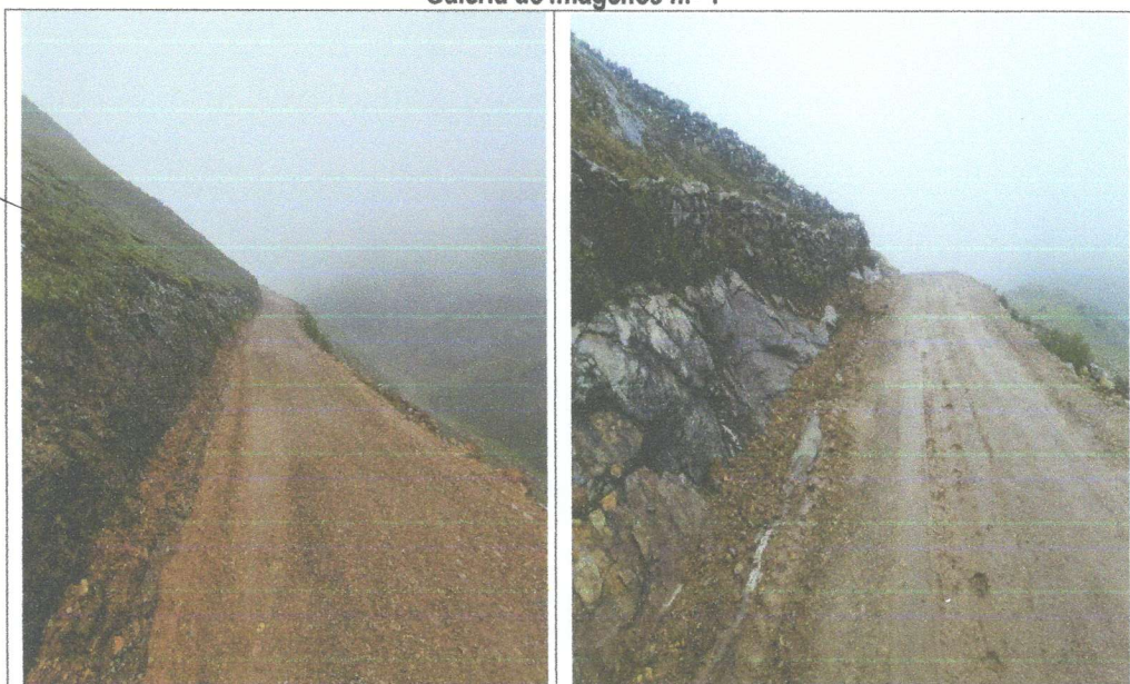
Imagen n.º 2: La cuneta de tierra en la progresiva 1+150, presenta empozamiento la cual humedece el lado derecho de la capa de afirmado de la carretera, aproximadamente en una distancia de quince (15) metros.
