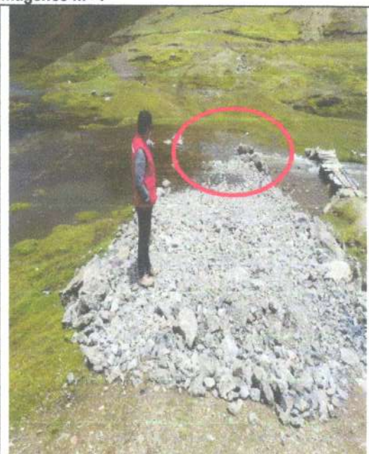
Imágenes n.ºs 7 y 8: En la progresiva 7+400, se ha colocado piedra para conformar el terraplén, sin embargo, se ha represado el agua que fluye de la laguna Ampatoccocha, imposibilitando la conformación de la capa de afirmado.
