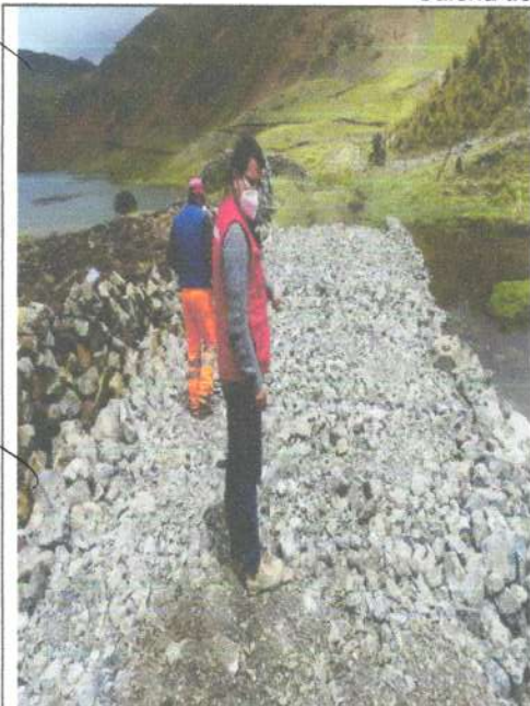
Imágenes n.ºs 7 y 8: En la progresiva 7+400, se ha colocado piedra para conformar el terraplén, sin embargo, se ha represado el agua que fluye de la laguna Ampatoccocha, imposibilitando la conformación de la capa de afirmado.
