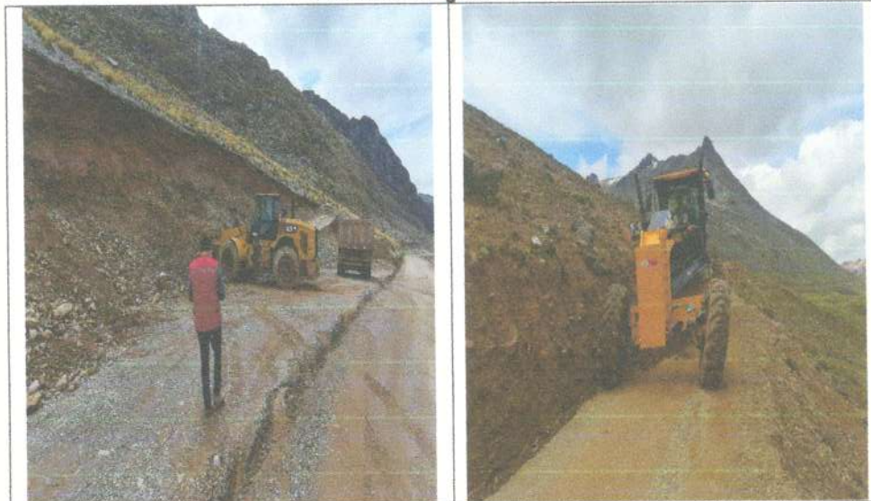
Imágenes n.º 3 y 4: Se muestra que la excavadora, volquete y motoniveladora vienen operando en la intervención vial; sin embargo, el Rodillo liso vibratorio mínimo 09 TON y el Cisterna mínimo 1000 GAL, no están operado en el lugar de intervención vial ni en el área de influencia del proyecto.
