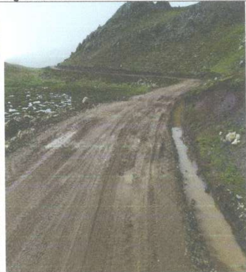
Imagen n.º 6: La cuneta de tierra en la progresiva 0+300, presenta empozamiento en la cuneta de tierra la cual humedece el lado derecho de la capa de afirmado de la carretera, aproximadamente en una distancia de veinte (20) metros.
