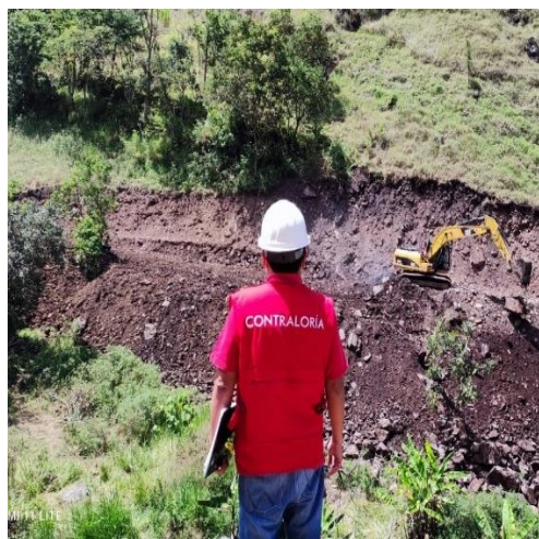
Apertura de tramo de carretera en el sector Tosten – Nogal, utilizando una excavadora sobre orugas.
