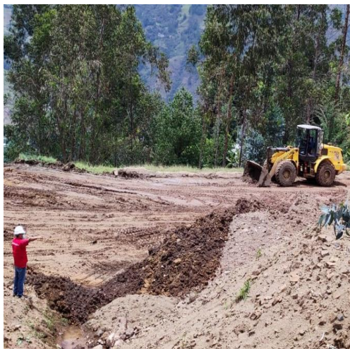
Acopio de material excedente en el sector Pan de Azúcar utilizando un cargador s/llantas.
