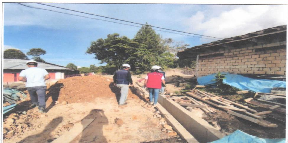
**Imagen n.° 8:** Durante el recorrido de la obra, se evidencia que el área de trabajo no se encuentra señalizada con elementos de seguridad.
