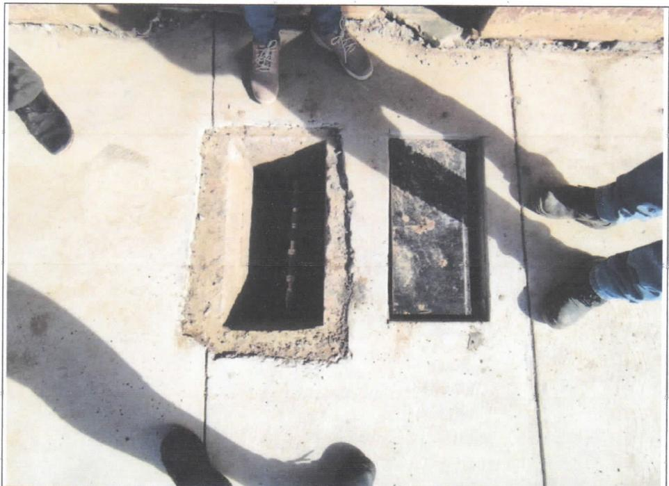
Imagen n.º 10: Se observa cajas de conexiones domiciliarias de agua y desagüe sin tapas y sin ningún tipo de señalización ni protección.
