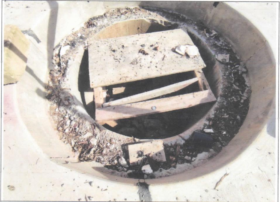
Imagen n.º 9: Se aprecia un buzón sin techo y sin ningún tipo de señalización.
