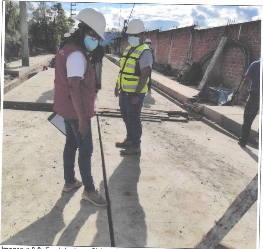
Imagen n.º 2: En el Jr. Jorge Chávez C-1, se advierte la falta de llenado de juntas de cunetas y de la losa de concreto.
