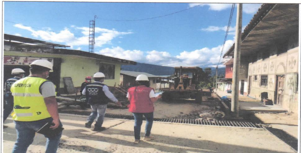
**Imagen n.° 7:** Durante el recorrido de la obra, se evidencia que el área de trabajo no se encuentra señalizada con elementos de seguridad.
