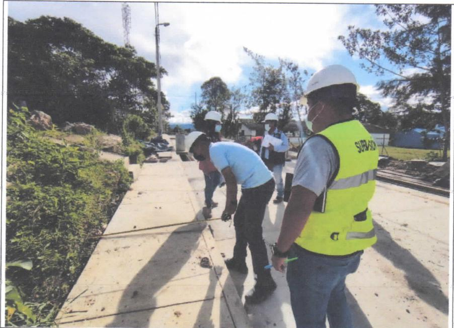
**Imagen n.º 4:** En el Jr. San Miguel C-6, la vereda del lazo izquierdo tiene 1m de ancho y en el lado derecho no se ha ejecutado.
