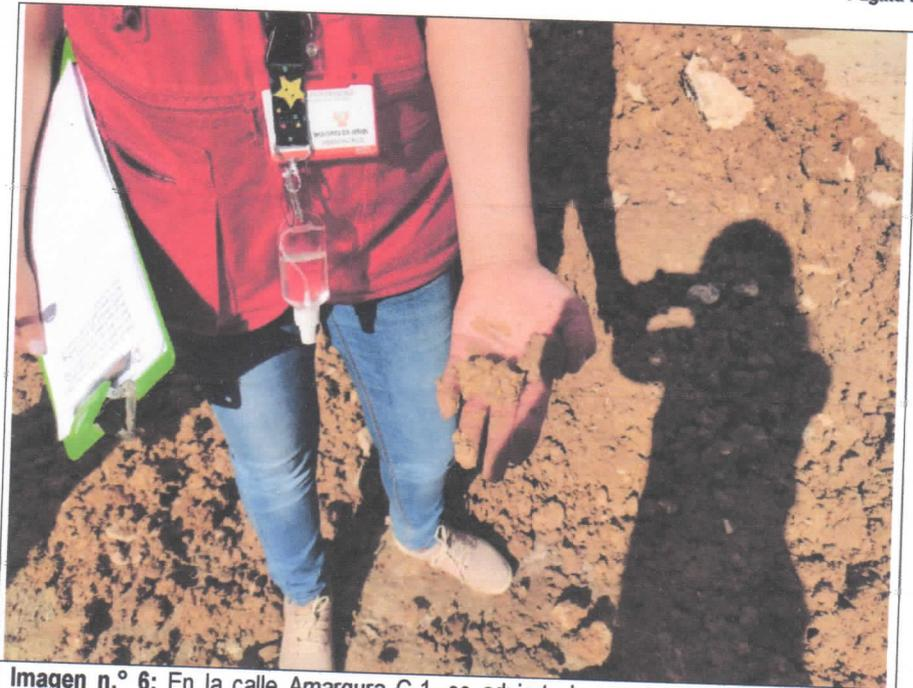
Imagen n.º 6: En la calle Amargura C-1, se advierte la construcción de una vereda (colocación de afirmado y compactación) con material saturad (barro); asimismo, se advierte que este (material saturado), viene siendo colocado sobre una vereda existente.
