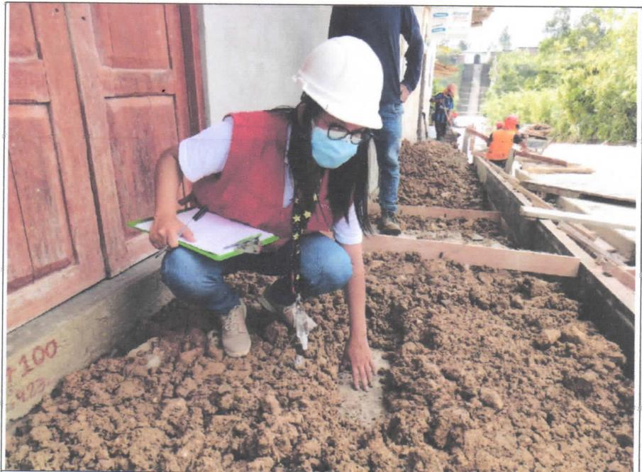
**Imagen n.º 5:** En la calle Amargura C-1, se advierte la construcción de una vereda (colocación de afirmado y compactación) con material saturado (barro); asimismo, se advierte que este (material saturado), viene siendo colocado sobre una vereda existente.
