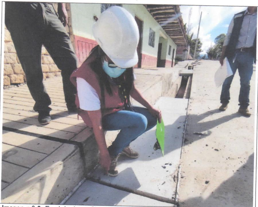
Imagen n.º 3: En el Jr. Jorge Chávez C-1, se advierte la falta de llenado de juntas de cunetas y de la losa de concreto.
