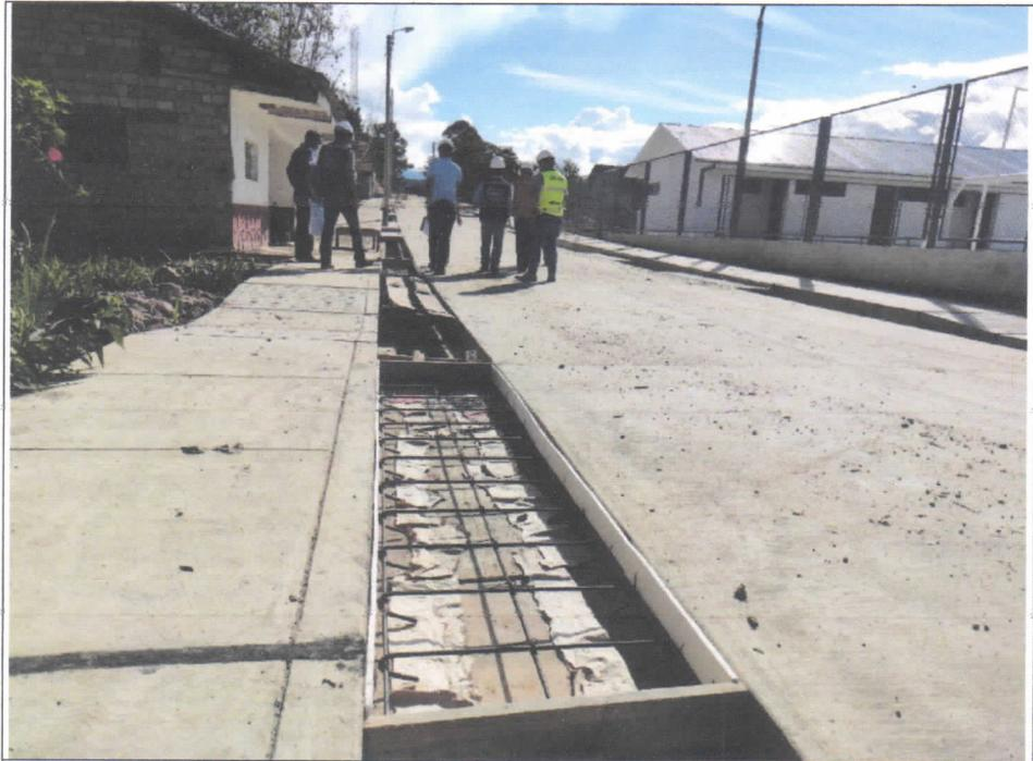
Imagen n.º 11: Se aprecia el techo de una cuneta con acero expuesto y sin ningún tipo de protección y/o señalización.
