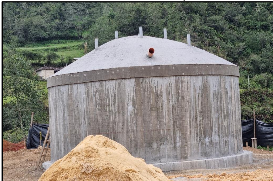
Imagen n.º 11 Se muestra la forma asimétrica de la cúpula del reservorio
