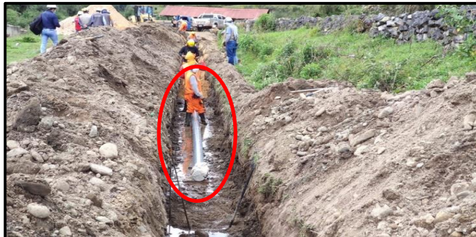
Imagen n.º 3 Se muestra parte de la tubería de la línea de conducción que venía instalando sin considerar la cama de arena
