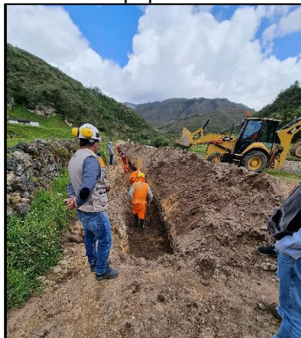
Imagen n.º 5 Se muestra el material de excavación con el que se venía realizando el relleno con material propio sin seleccionar
