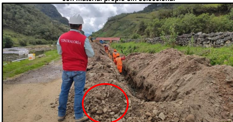
Imagen n.º 5 Se muestra el material de excavación con el que se venía realizando el relleno con material propio sin seleccionar
