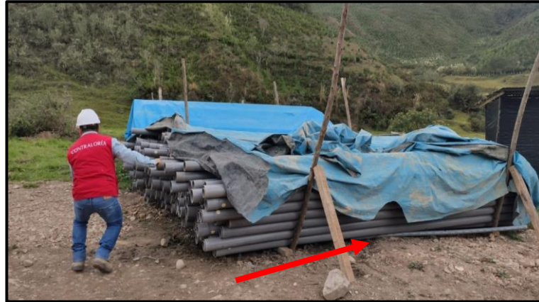
Imagen n.º 6 Se muestra la tubería PCV-U de 6" incorrectamente almacenada
