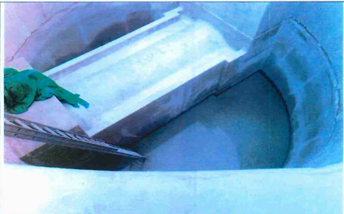
Vista de la cámara CIS-01, donde se impulsará las aguas residuales, para que los trabajos de empalmes finales al colector Canto Grande se realicen en condición seca.
