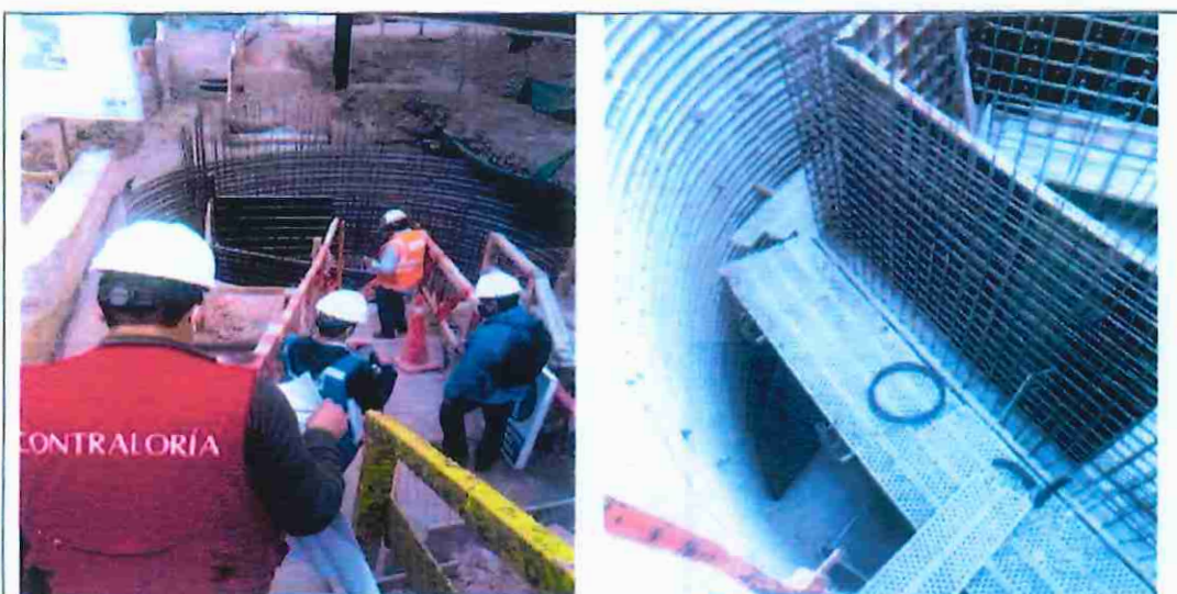
Vista Cámara CDE-01 – Encofrado de muros laterales de la cámara
