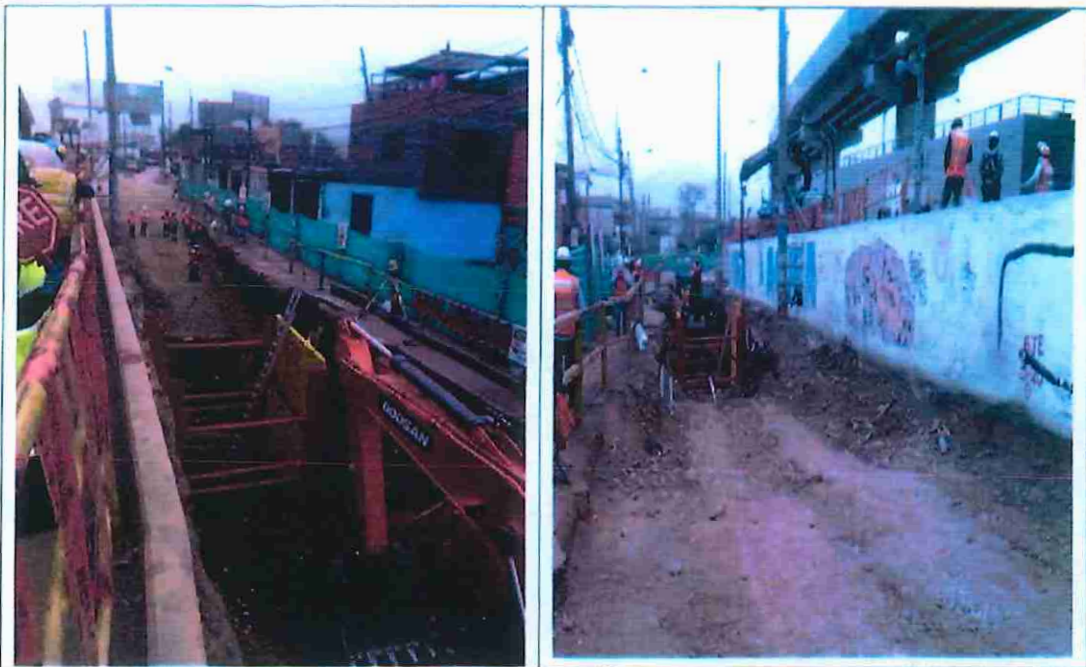
Trabajos de excavación entre los buzones BZP-02 al CD-03
