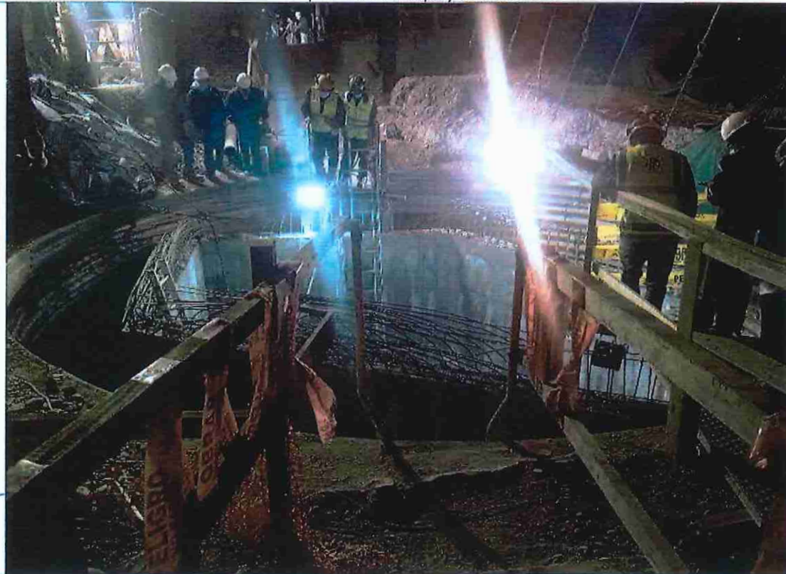
Foto n.º 2: Vista de labores del personal de Sedapal y contratista sobre la cámara CDE-01
