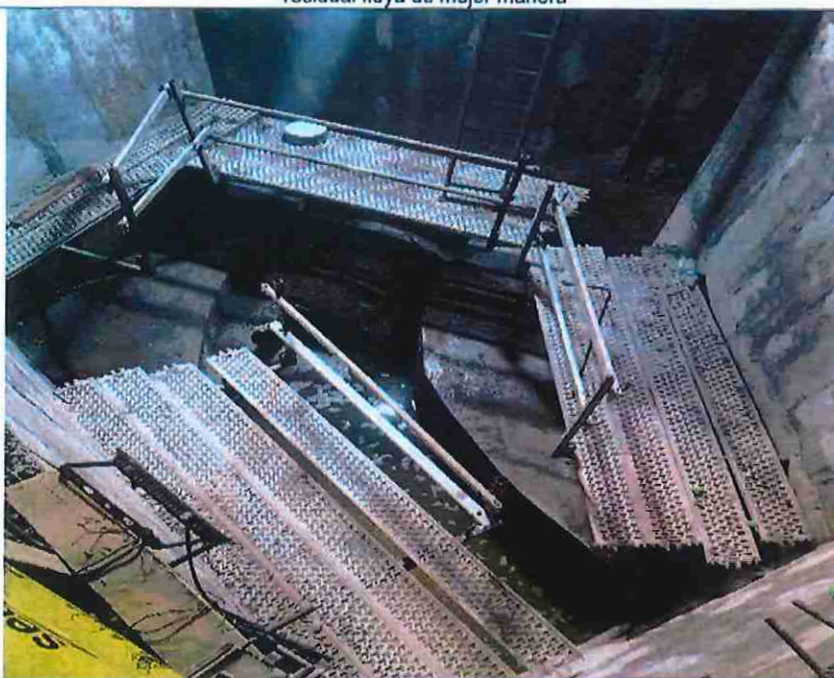
Foto n.º 8: Vista de la tubería de concreto realizado el corte con el cual se tiene una ventana que permite que el agua residual fluya de mejor manera
