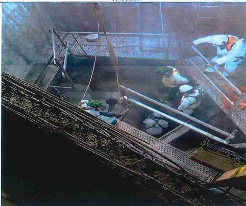
Foto n.º 6: Reinicio de las labores de corte sobre la tubería de concreto, nivel de agua residual nuevamente controlado
