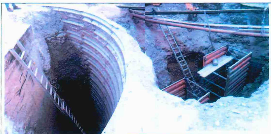
Vista de izquierda a derecha entre CD-02 al CD-4 (Solución considerada por Sedapal – Tramo de tubería de 1200 mm en una longitud de 15 m)
