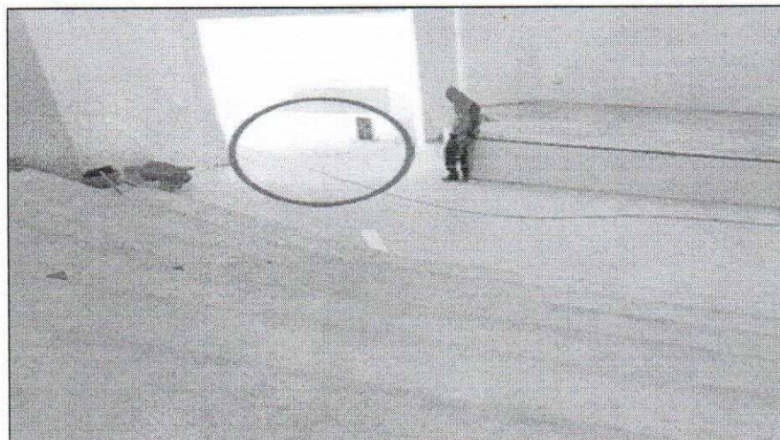
FOTOGRAFÍA N° 25 EL PISO DEL AUDITORIO Y EL INGRESO A ESTE TIENEN EL MISMO NIVEL; ADVIRTIÉNDOSE QUE EL DRENAJE PLUVIAL DE ESTA ZONA NO GARANTIZA EL DESFOGUE
