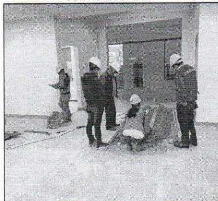
FOTOGRAFÍA N° 9 SE EVIDENCIA QUE SE ESTÁN REALIZANDO LABORES DE HABILITACIÓN Y COLOCACIÓN DE CONTRAZÓCALOS
