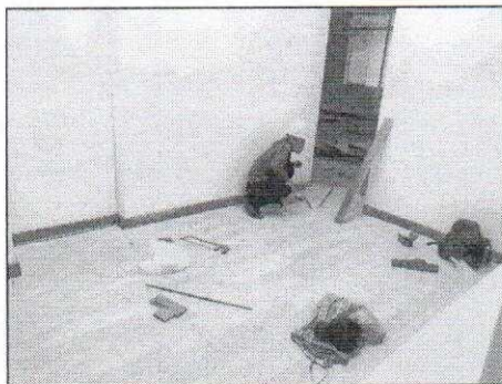
FOTOGRAFÍA N° 21 INSTALACIÓN DE CONTRAZÓCALOS DE MADERA
