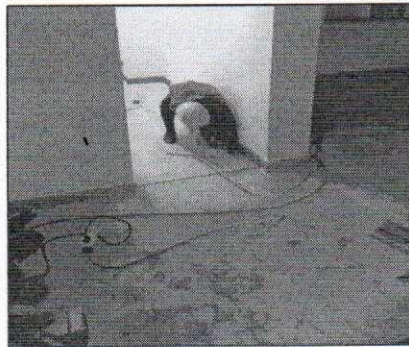
FOTOGRAFÍA N° 22 INSTALACIÓN DE CONTRAZÓCALOS DE MADERA
