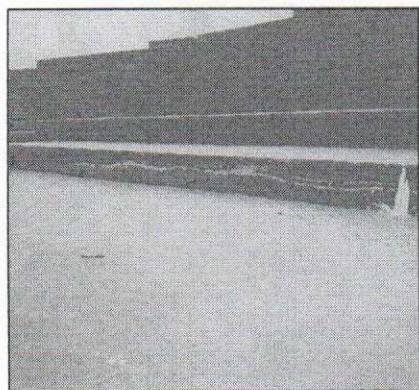
FOTOGRAFÍA N° 25 EL PISO DEL AUDITORIO Y EL INGRESO A ESTE TIENEN EL MISMO NIVEL; ADVIRTIÉNDOSE QUE EL DRENAJE PLUVIAL DE ESTA ZONA NO GARANTIZA EL DESFOGUE
