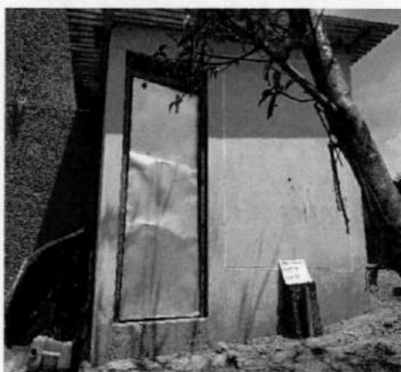
Panel fotográfico n.º 30-UBS Coordenadas (E:552589 N: 8574601) Obs. Vivienda sin conexión a servicio de agua potable.
