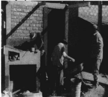
Imagen n.º 12 Vigas de madera, tarrajeo exterior e interior, e instalación de tuberías y accesorios de agua, desagüe y ventilación en la caseta para UBS
