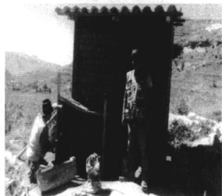
Imagen n.º 13 Instalación de cobertura con teja andina sobre vigas y correas de madera, construcción, tarrajeo del lavadero
