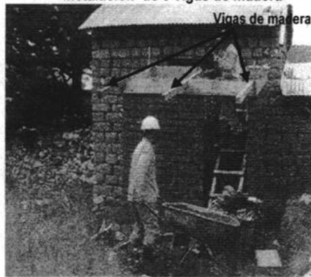
Imagen n.º 8 Caseta para UBS sin columnas concreto armado encofrado de la viga de amarre e instalación de 3 vigas de madera
