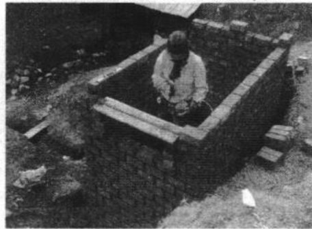
Imagen n.º 6 Construcción de dintel sobre la ventana, y muro de ladrillo tipo soga y cara vista, y sin las columnas de concreto en caseta para UBS
