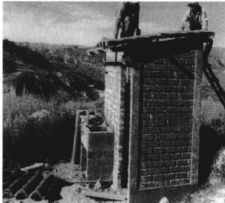
Imagen n.º 10 Instalación de cobertura con teja andina sobre vigas y correas de madera
