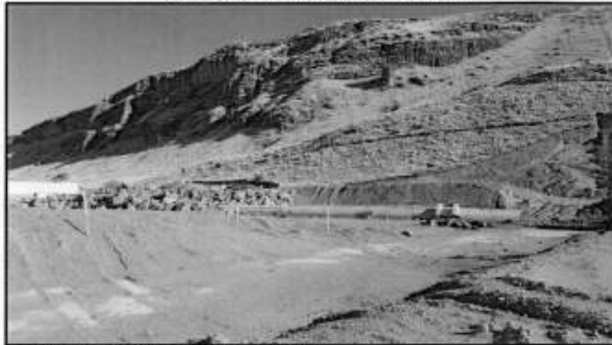
IMAGEN N° 5 GALERÍA DE LA REPRESA PALLALLAJE
