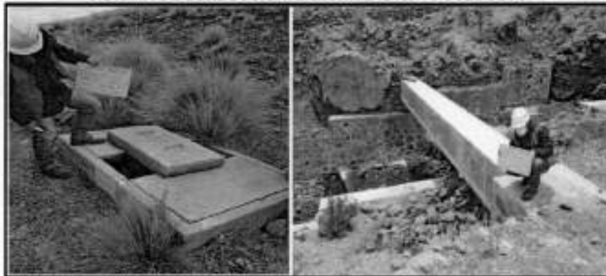
IMAGEN N°s 6 y 7 SISTEMA DE CONDUCCIÓN: BUZÓN DE GIRO - ACUEDUCTO
