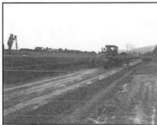
Perfilado de la sub rasante con motoniveladora Km. 02+080 Fuente: Valorización de obra n.º 03 (apéndice n.º 75).
