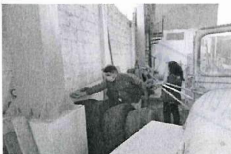
Medición de la pared lateral derecha entrando junto a la cual se observa presencia de llantas, maderas y un vehículo.
